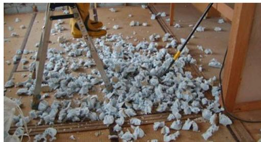
図 バールによる分離断熱材片
