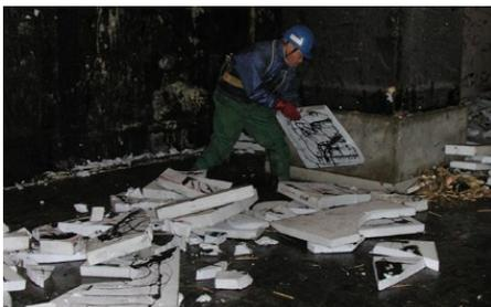
図 バールによる分離断熱材片
