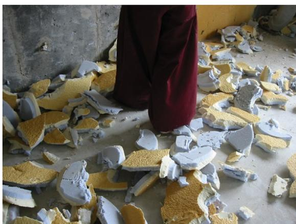
図 ケレン棒による分離断熱材片
