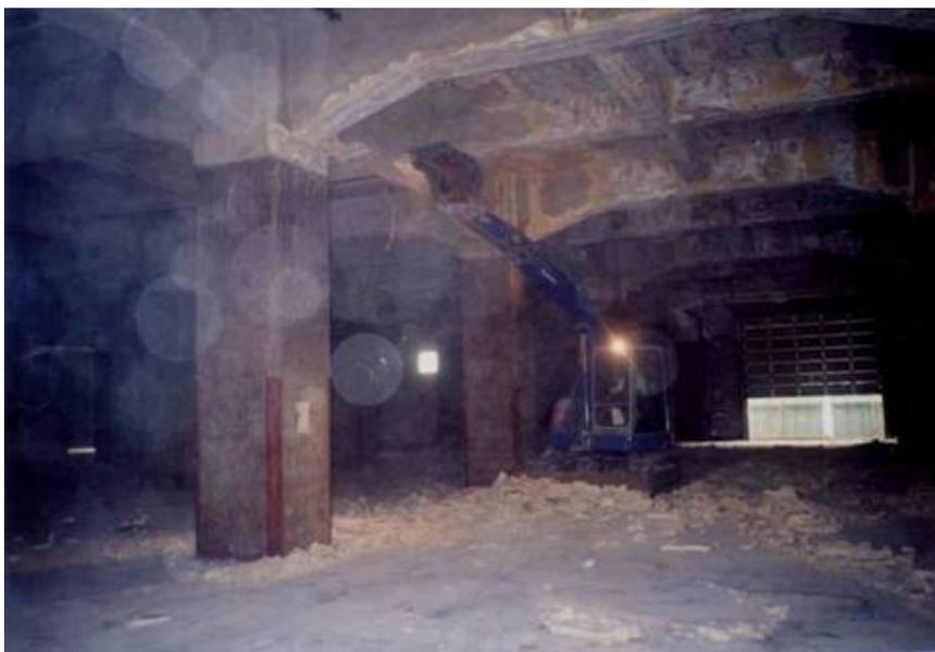
図 冷蔵倉庫におけるフロン断熱材の引き剥がしイメージ
