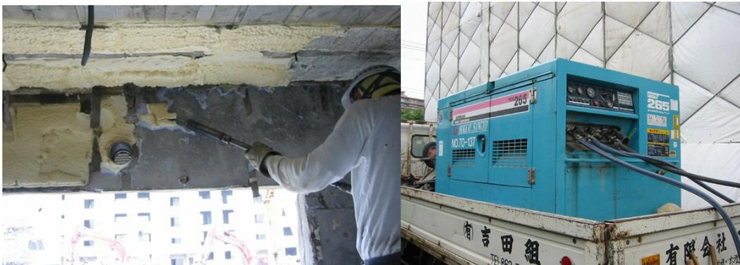
図 エアークンプレッサーを使用した断熱材の分離作業
