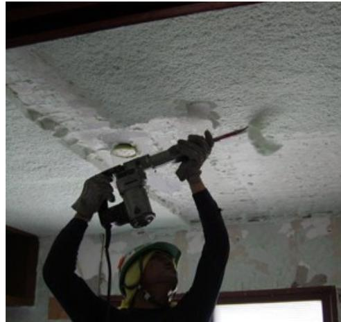
図 電動ピックを押し込む瞬間 図 電動ピックによって断熱材が分離する瞬間
