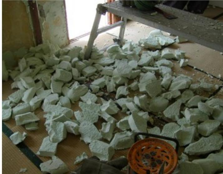
図 電動ピックによる分離断熱材片
