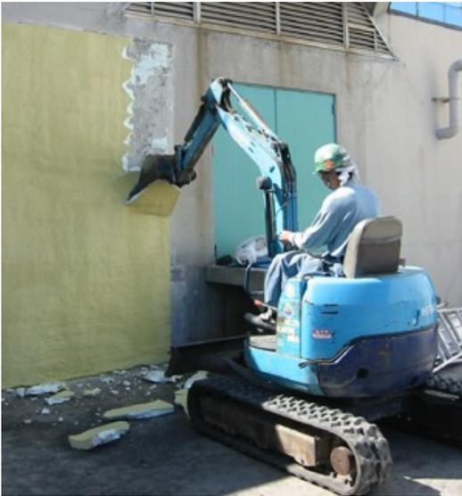
図 重機による断熱材の分離作業
