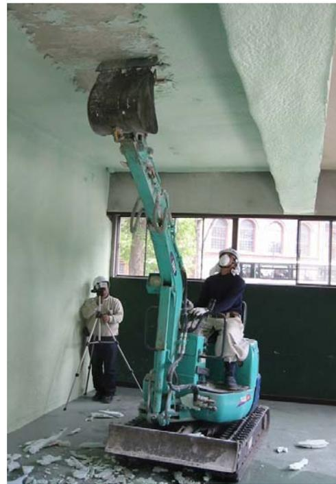
図 重機による断熱材の分離作業
