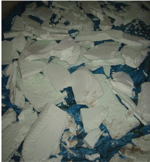
図 重機による分離断熱材片
