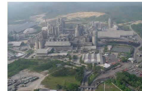
日本環境省の協力によりフロン破壊施設を設置したインドネシアのセメント工場
