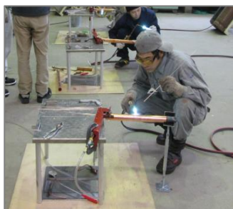
水平配管のろう付け
