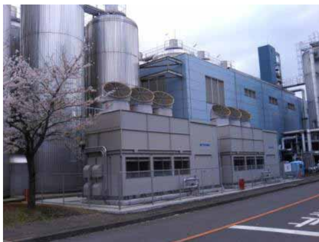
アンモニア冷却機 全景
