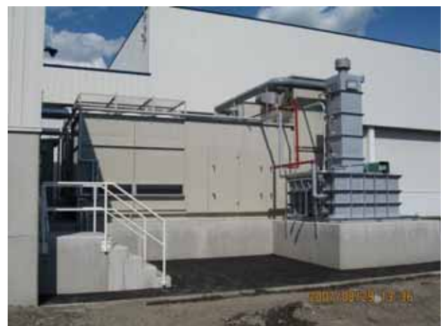
アンモニア冷却機 全景
