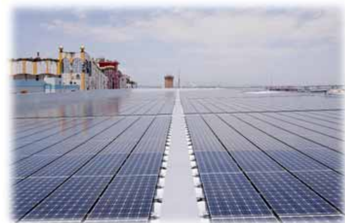
太陽光発電システム
