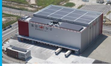
試験的な導入から始め、現在では庫容量ベースで過半数以上が自然冷媒。断熱材のノンフロン化も推進。
