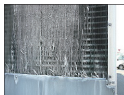
室外機の腐食
