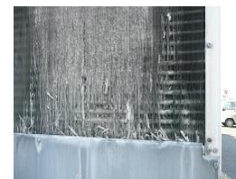
室外機の腐食
