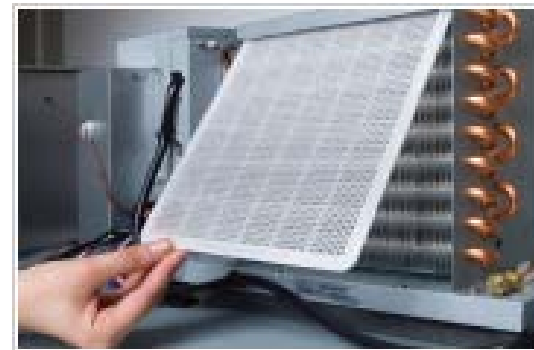
業務用冷蔵冷凍庫 フィルタ清掃
