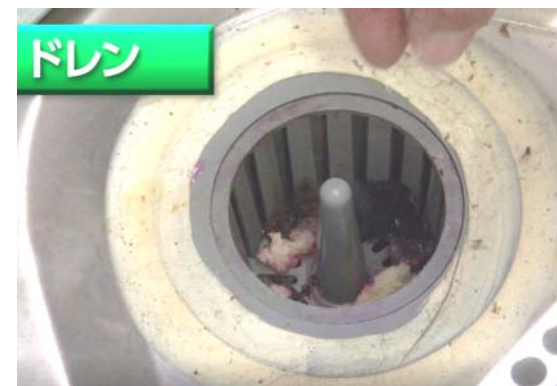
ショーケースのドレン点検
