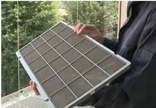
フィルタの目視点検
