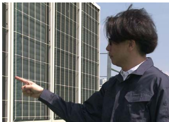
室外機を目視点検
