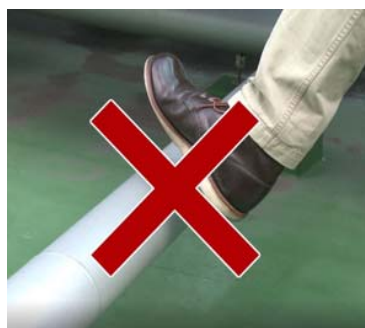
冷媒配管の防熱を踏まない
