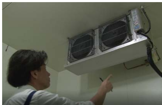
ウォークイン冷凍冷蔵庫 冷却器の霜付き等の点検
