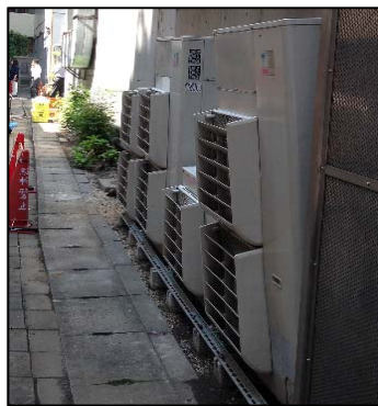
倒れそうな室外機
