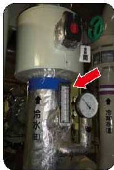
冷却水及び冷水の出入口温度
