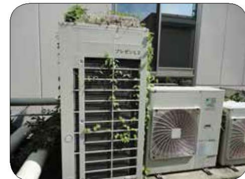
草で覆われた室外機
