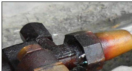
フレア継手部の劣化
