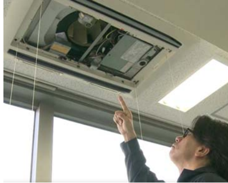
室内機を目視点検
