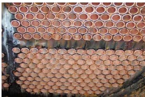
水冷熱交換器伝熱管の劣化
