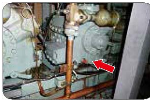
圧縮機周辺の油のにじみの確認
