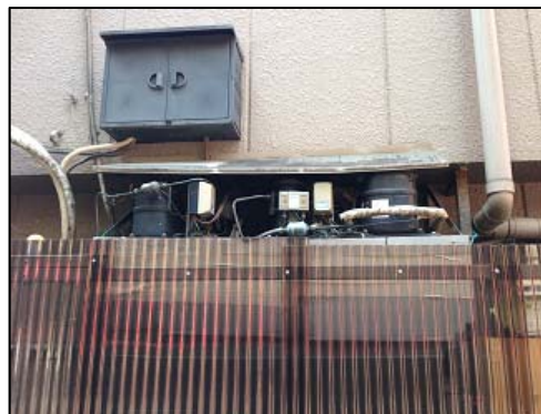
雨ざらしの室外機
