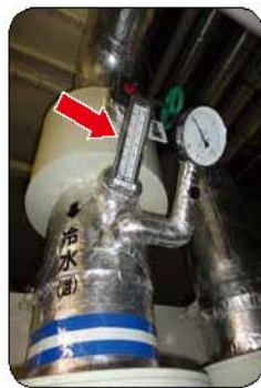
冷却水及び冷水の出入口温度
