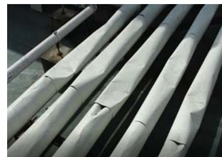
冷媒配管の防熱の損傷
