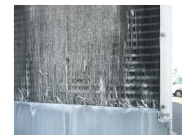
室外機の腐食
