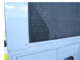
室外機の油にじみ
