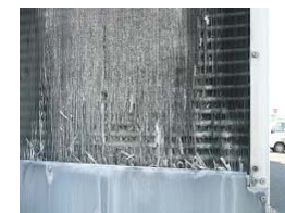
室外機の腐食
