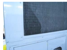
室外機の油にじみ
