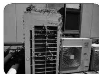
草で覆われた室外機
