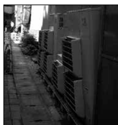
倒れそうな室外機
