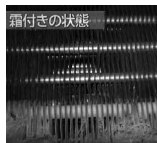
ショーケースの熱交換器点検
