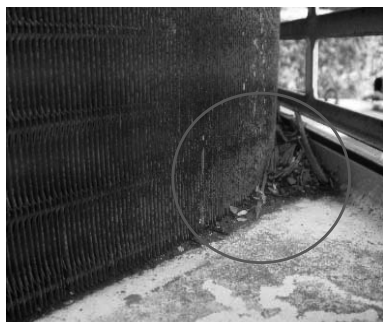
⑧ 空冷凝縮器
