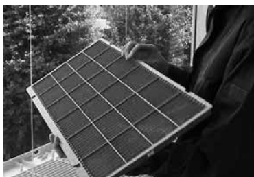
フィルタの目視点検
