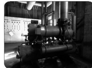
冷凍機異常振動・異常運転音 異常発停、各圧力・電圧・電流
