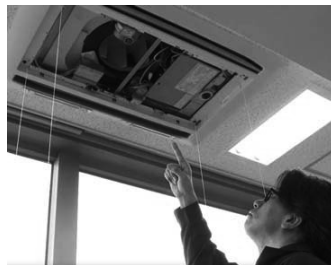
室内機の目視点検
