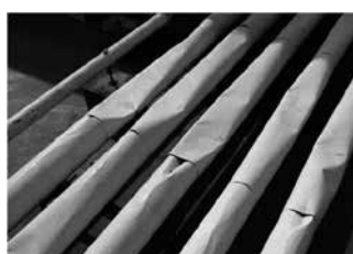
冷媒配管の防熱を踏まない
