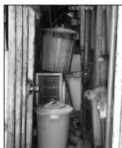
吹き出し口が塞がった室外機
