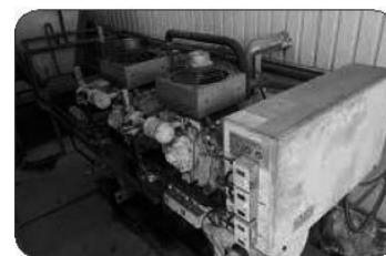
開放型冷凍機異常振動、異常運転音の確認
