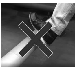
冷媒配管の防熱を踏まない
