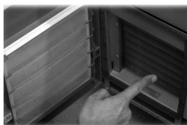
コールドテーブル 点検及びフィルタ清掃
