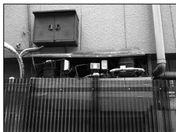
雨ざらしの室外機
