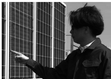
室外機の目視点検
