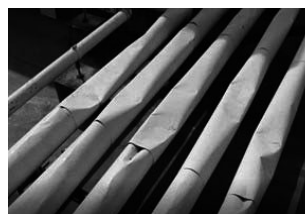
冷媒配管の防熱の損傷
