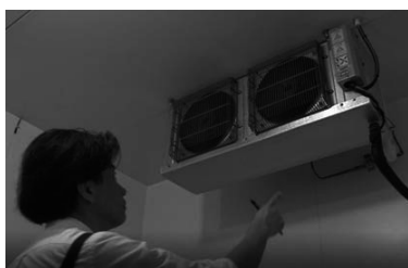
ウォークイン冷凍冷蔵庫 冷却器の霜付き等の点検
