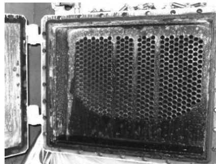
⑦ シェルアンドチューブ（凝縮器）
