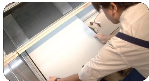
ショーケースの床板をはずします。
