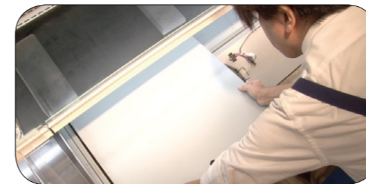
床板を外します
