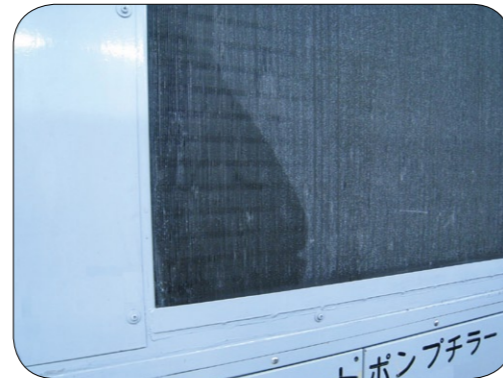
熱交換器の油のにじみ
