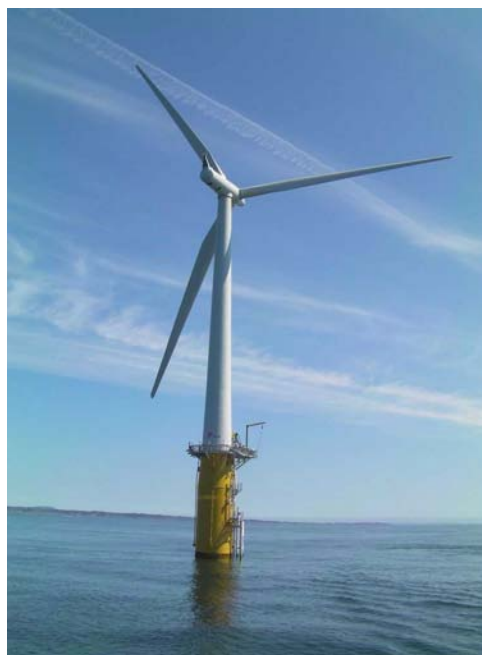
図 2-1-11 浮体式洋上風力発電施設「Hywind」
