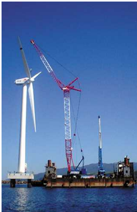
図 2-1-9 SEP 船による風力発電施設据付作業状況（北海道・せたな町）
