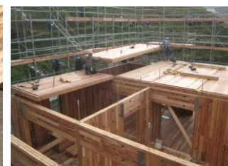
CLTを用いた施工例
