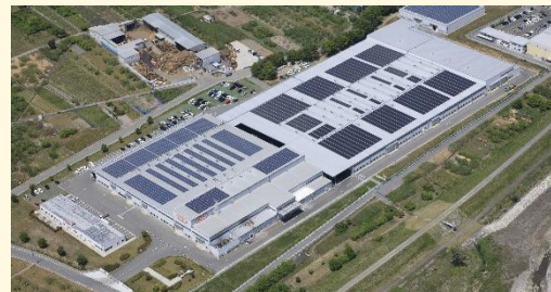
工場の屋根置き太陽光発電
