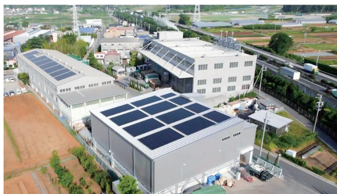
千両リサイクルプラント（愛知県豊川市）
