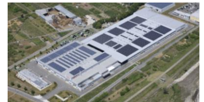
工場の屋根置き太陽光発電
