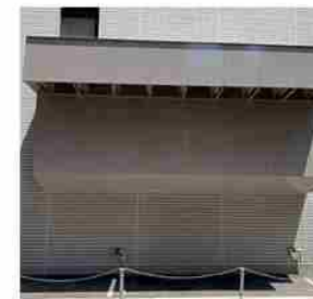
発電機用給排気口ダクト高上げ
