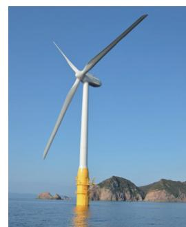
長崎県五島市梶島沖の浮体式洋上風力発電の2メガワット風車
