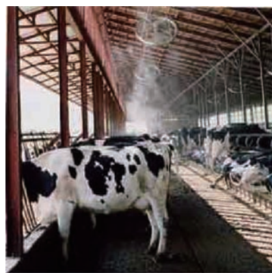
▲ 噴霧、送風システム 出典24より
