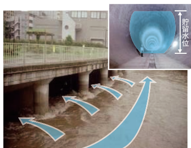
洪水調節施設（地下調節池） 出典8より
