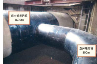
複数の上水道を連絡管で結ぶことで、相互の水融通が可能となり、断水被害を回避または軽減することができます。東京都及び川崎市が、非常時に浄水を相互に融通するために、双方の水道管が近接する場所で登戸連絡管を接続しました。(出典19より)
