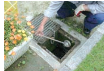
雨水マス調査*
