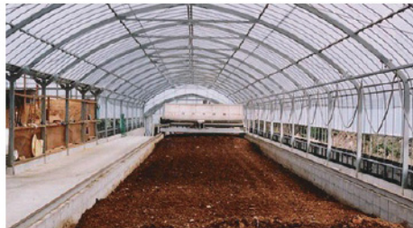
市民と協働による生ごみ堆肥化プラント
