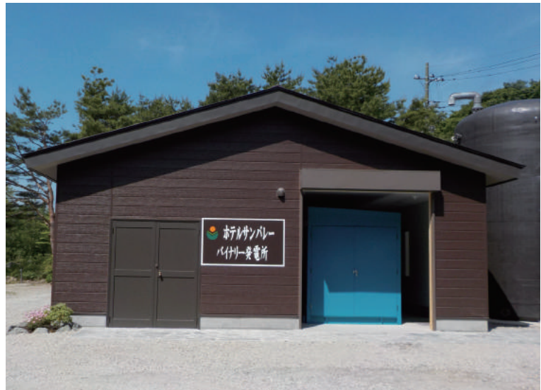
バイナリー発電用冷却水による重油ボイラー代替
