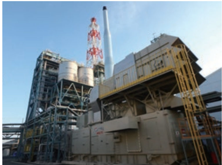
環境配慮型コージェネレーションシステム
