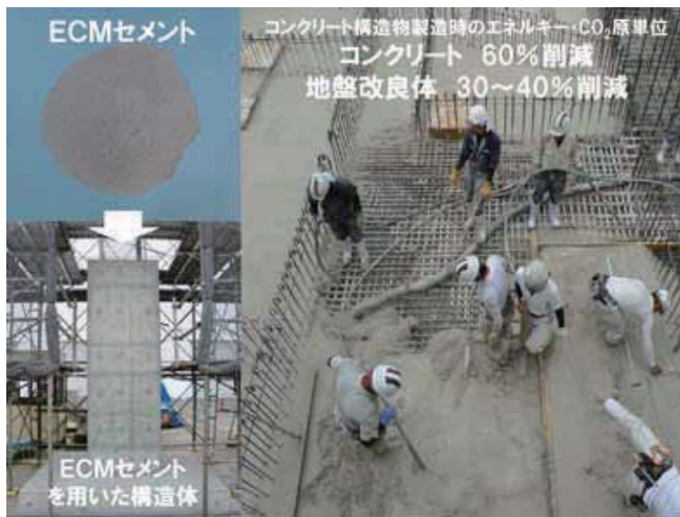
ECMセメントで建設構造物の省CO 2 を実現
