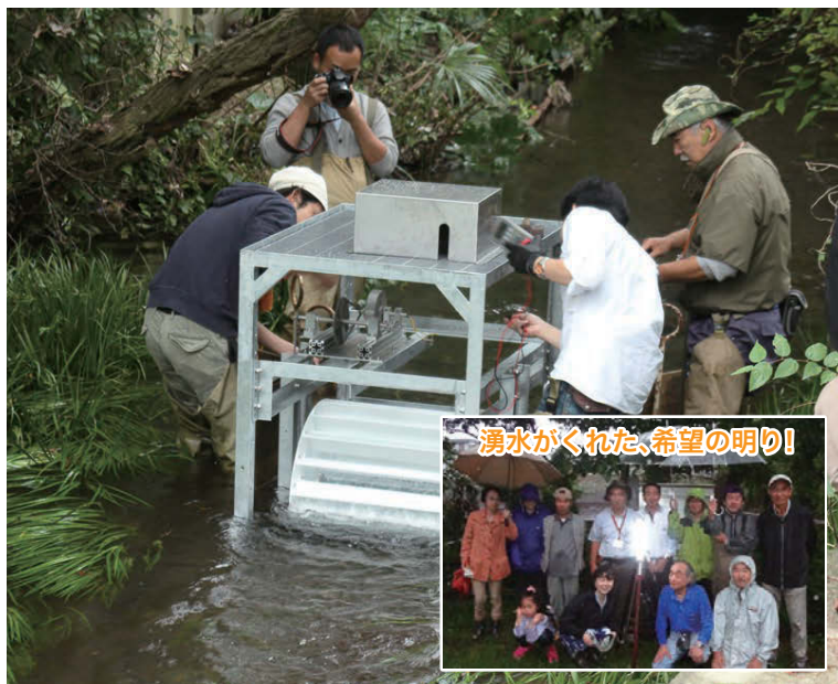
湧水小水力発電機の据付け作業中
