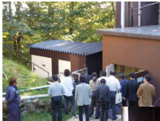
ヒートポンプ施設
