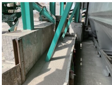
開発したアルカリ活性材料コンクリートでの鉄骨柱の保護コンクリート補修工事の様子
