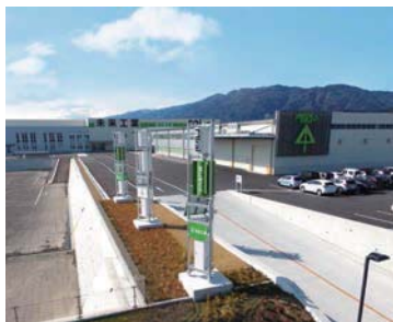
垂井工場全景
