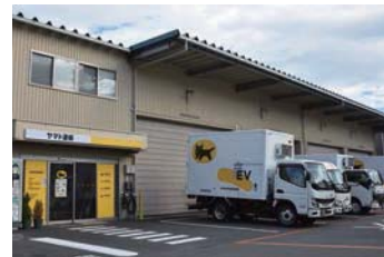
ヤマト運輸 高津千年営業所外観
