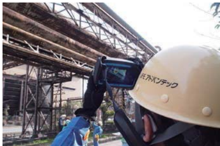
気体漏れ点検作業風景
