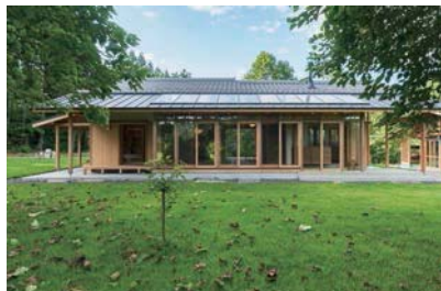
モデルハウスさとのえの南面写真
