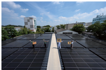
太陽パネルによる自家発電(PPA日本第1号)
