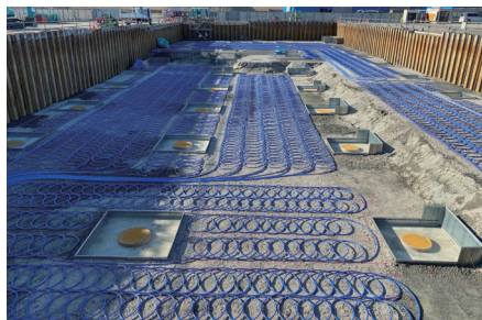
スリンキー式コイル埋設
