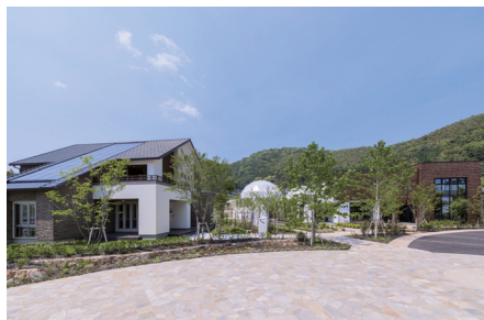
エルクの杜(全景):省エネや長期優良の仕組み等を常設展示
