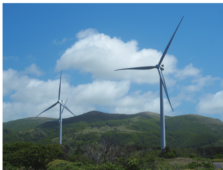
リエネ松前風力発電所
