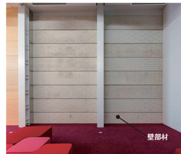
T-eConcrete/Carbon-Recycleの壁部材への実装例
