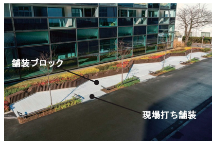
T-eConcrete/Carbon-Recycleの舗装コンクリートへの実装例
