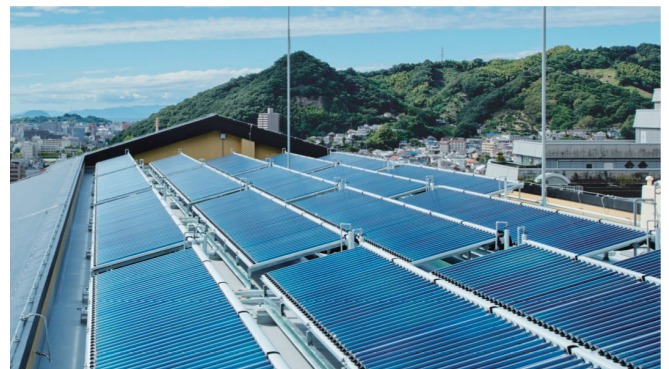
ホテルの屋上一面に設置された太陽光集熱パネル
