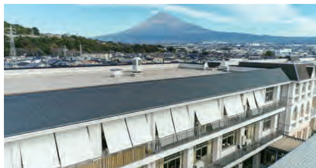
岩松北小学校に設置した「スタイルシェード」
