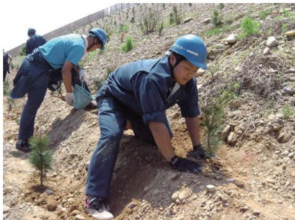
高さ最大15m、全長17.5kmの防潮堤が建設「防潮堤法面へ植栽」
