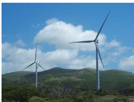
リエネ松前風力発電所
