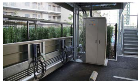
EVロータリー制御盤本体と6kW 充電器
