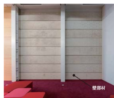
T-eConcrete/Carbon-Recycleの壁部材への実装例
