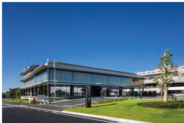
庁舎屋上に太陽電池モジュールを499枚設置
