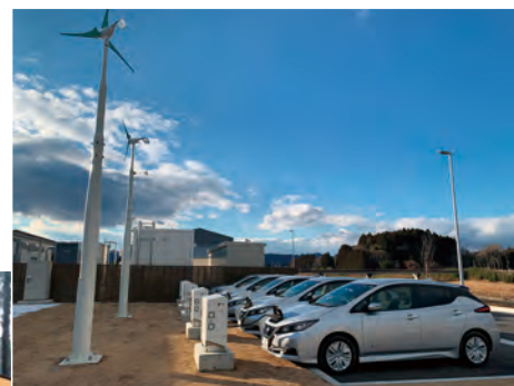
EV 充電を再生エネルギー 100%にする実証実験
