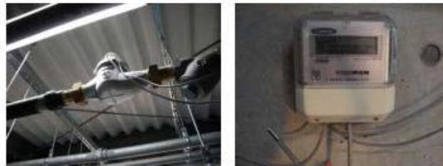
積算熱量計(40A,羽根車式)
