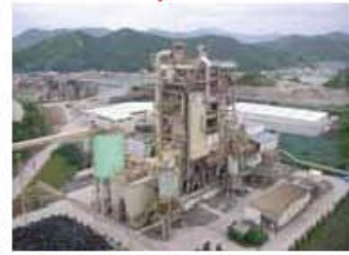
●2号発電設備 循環式流動層ボイラーで石炭の他、多種多様な燃料が使用可能です。
