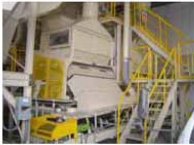
●比重差選別機 2次破碎機で破碎された木屑に混入する異物を比重差で選別します。
