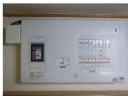
分電盤電力計測器:スマートELセンサ mutli
