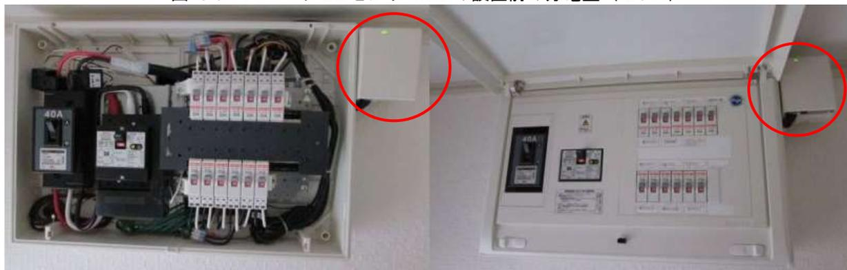
図 8.4 スマート EL センサ multi の設置後の様子 (ID014)
