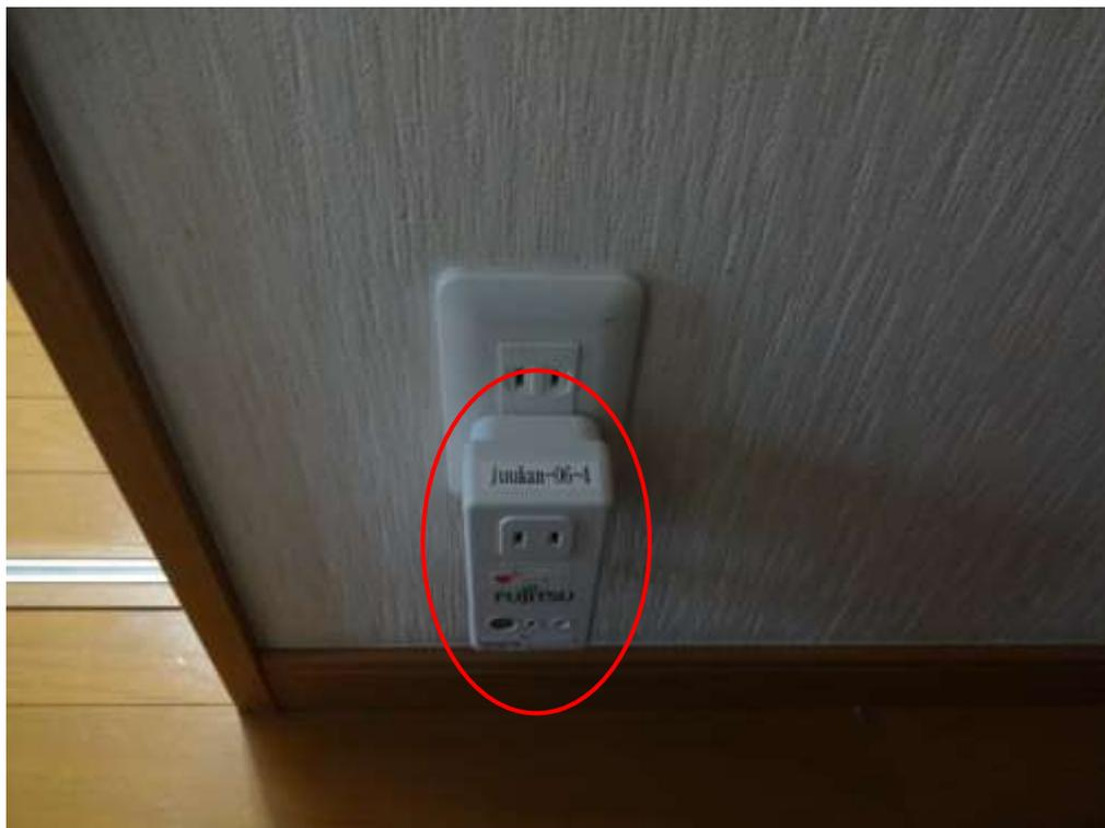
図 8.5 F-PLUG のリビング（コンセント）の設置例
