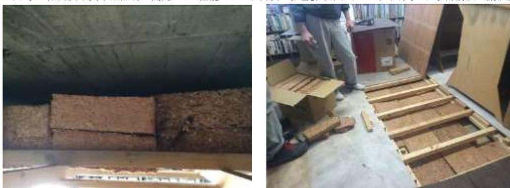
図 4-29 断熱材の施工状況
