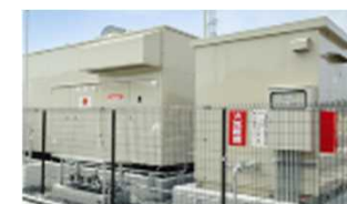
バイオディーゼル 非常用発電機
