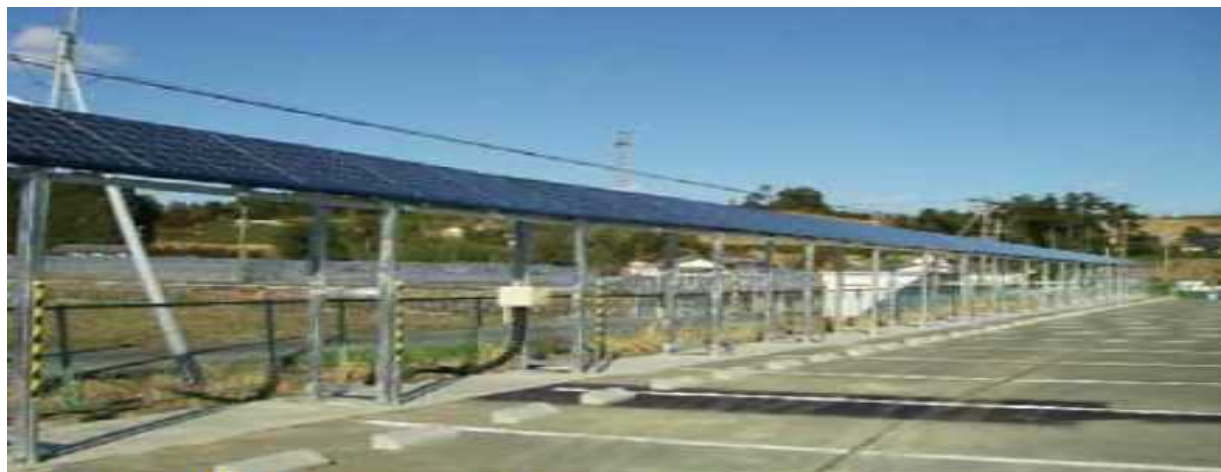
古紙回収の収益で小学校に設置した太陽光発電設備
