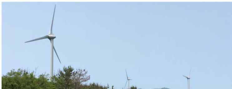
男鹿風力発電所 風車群
