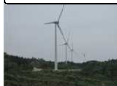
風力発電設備
