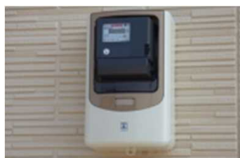
スマートメーター
