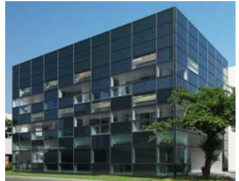
ZEB(例：大成建設実証棟)
