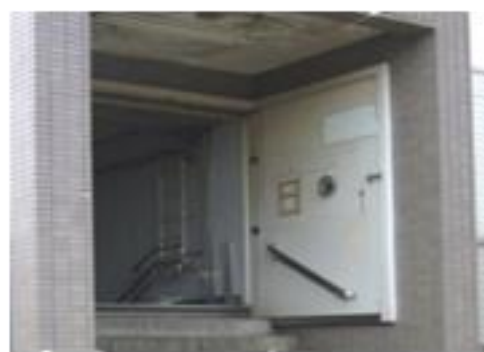
Tide protection door
