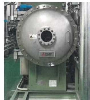
高効率オゾン発生装置の導入事例 [2]
