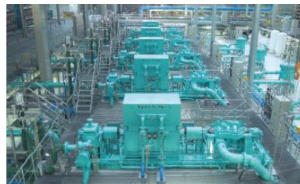
高圧ROポンプ・動力回収装置（福岡地区水道企業団まみずピア） [2]
