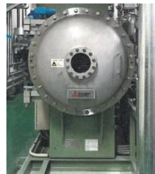
高効率オゾン発生装置の導入事例 [2]
